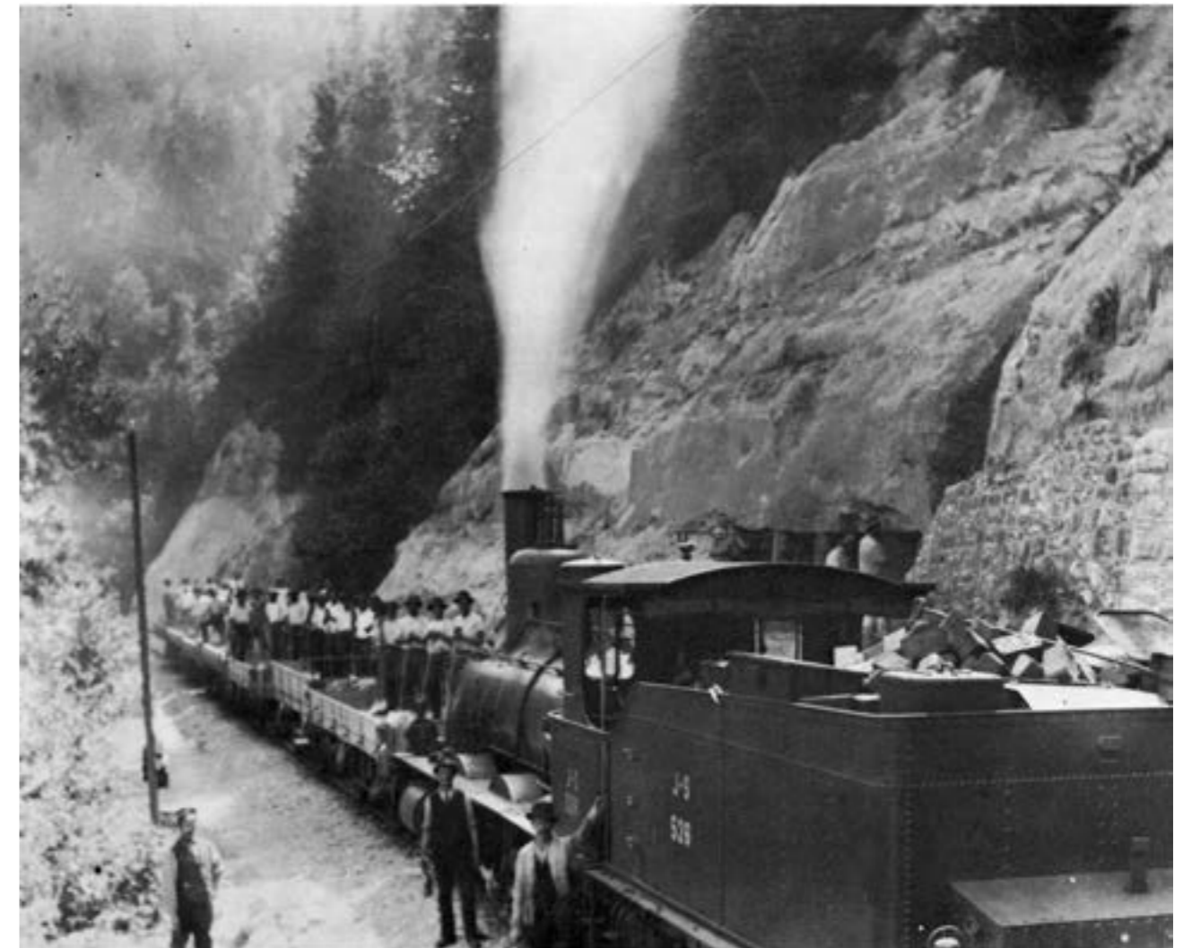
Train de travaux à la sortie du Tunnel de Villangeaux (Brivaux), 1875. Cent ans de chemin de fer dans la Broye
